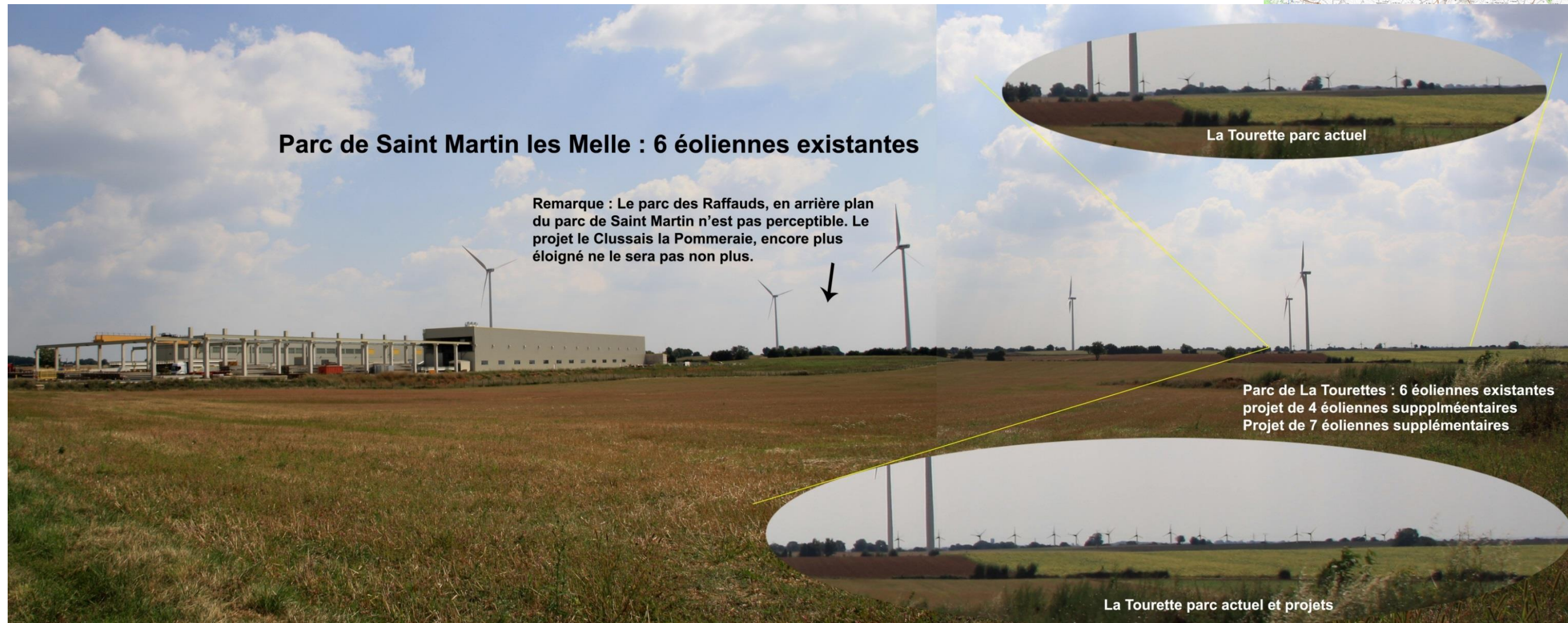
Photographie prise depuis les abords du bâtiment LB7 au nord ouest de Saint Martin les Melle permettant d'apercevoir sur la même vue les parcs de Saint Martin les Melle et des Raffauds. Altitude de l'observateur : 125 m Prise de vue initiale : 2 clichés assemblés – zoom 50 mm
